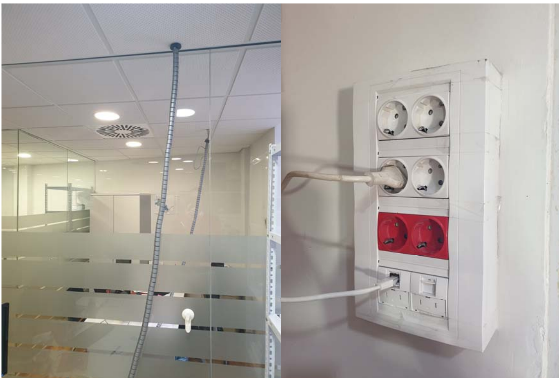
Sistema de puestos de trabajo a realizar. Tomas corriente, voz y datos
