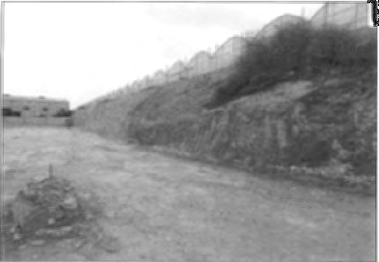
Fotografía 4: Vista del talud
