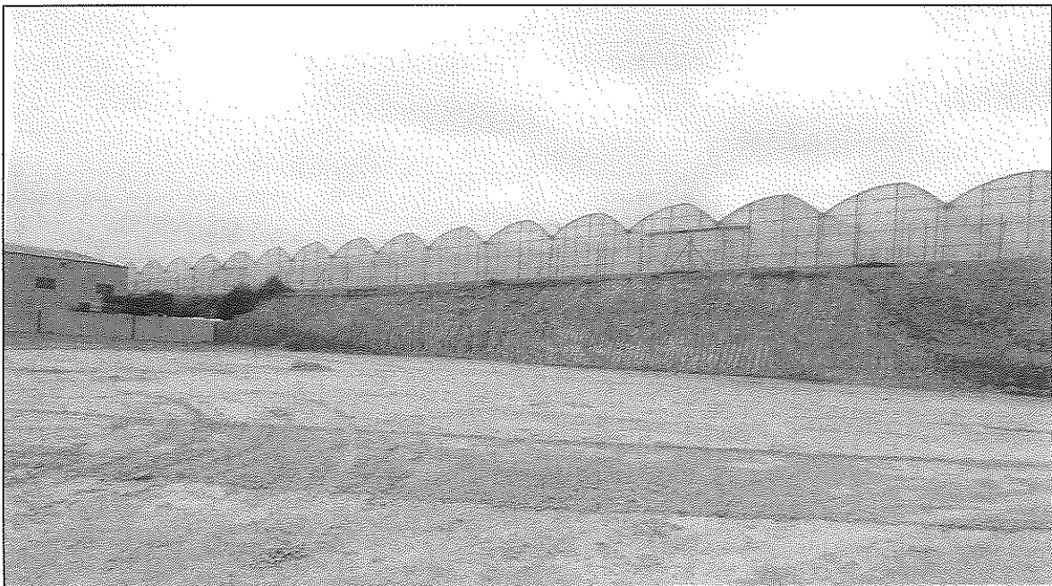
Fotografía 1: Vista del talud actual
