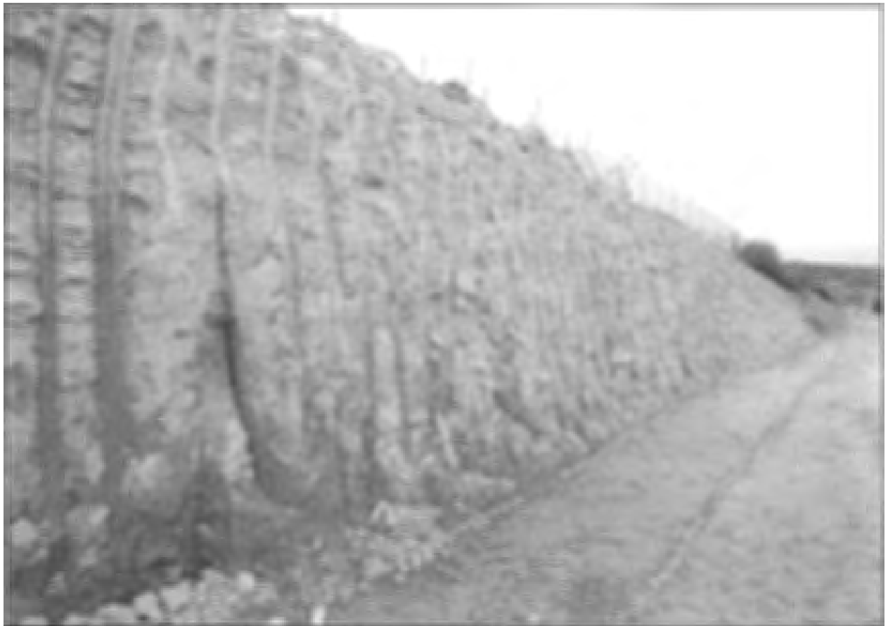
Fotografía 5: Vista del talud
